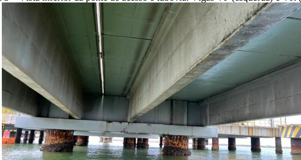
Figura 3 – Vista inferior da ponte de acesso e tubovia. Vigas VP (esquerda) e VR (direita)
