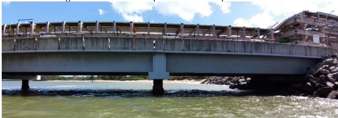
Figura 5 – Vista dos dois primeiros vãos da ponte de acesso
