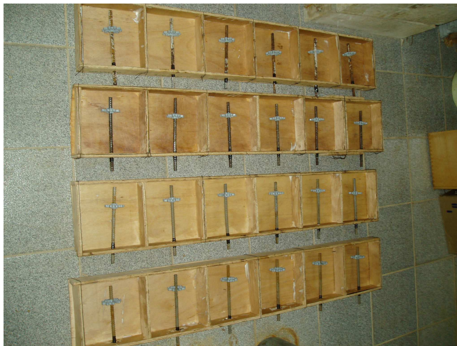
Figura 4.30 – Formas de compensado com as armaduras, prontas para serem concretadas.
