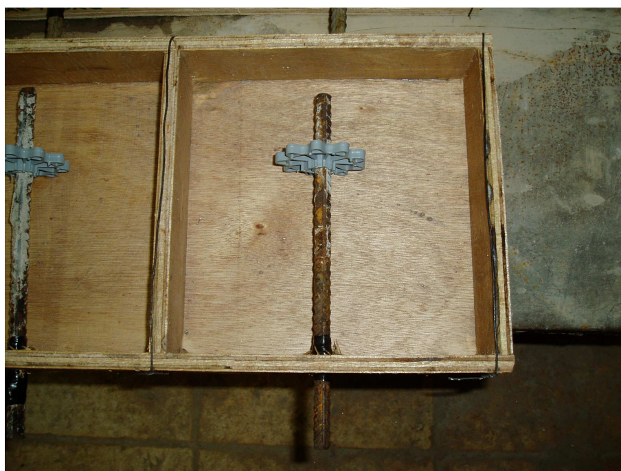
Figura 4.31 – Detalhe do espaçador plástico e da fita isolante na armadura, com a finalidade de manter o cobrimento e evitar uma diferença de aeração, respectivamente.
