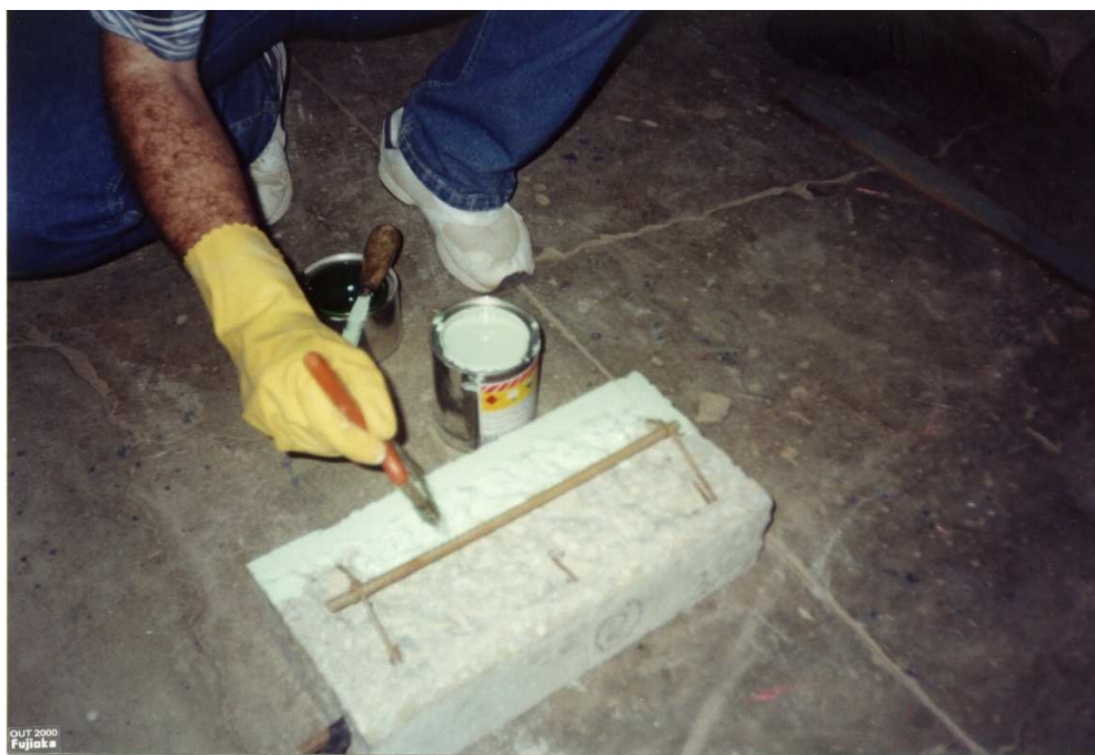
Figura 4.10 – Aplicação de adesivo epoxídico como ponte de aderência e barreira contra a difusão dos \text{Cl}^- do concreto base para o material de reparo (TINOCO, 2001).
