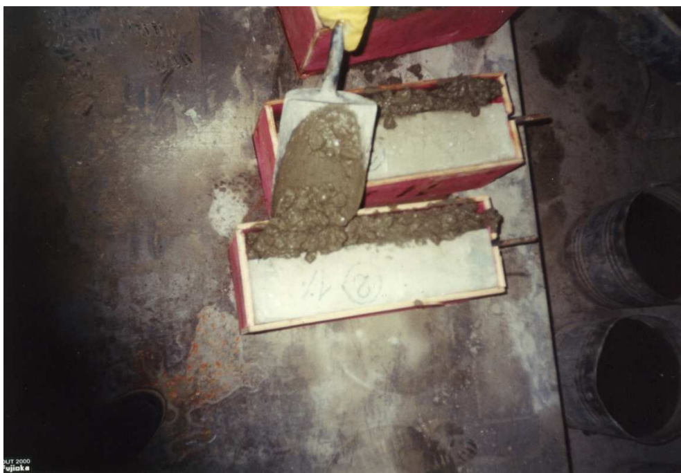
Figura 4.11 – Momento de aplicação do material de reparo (concreto referência) sobre o concreto contaminado com cloretos (TINOCO, 2001).
