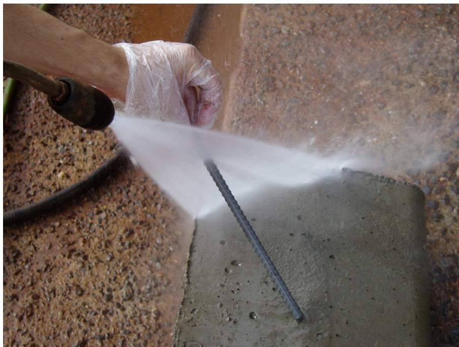
Figura 4.29 – Hidrojateamento, após jateamento de areia à seco.
