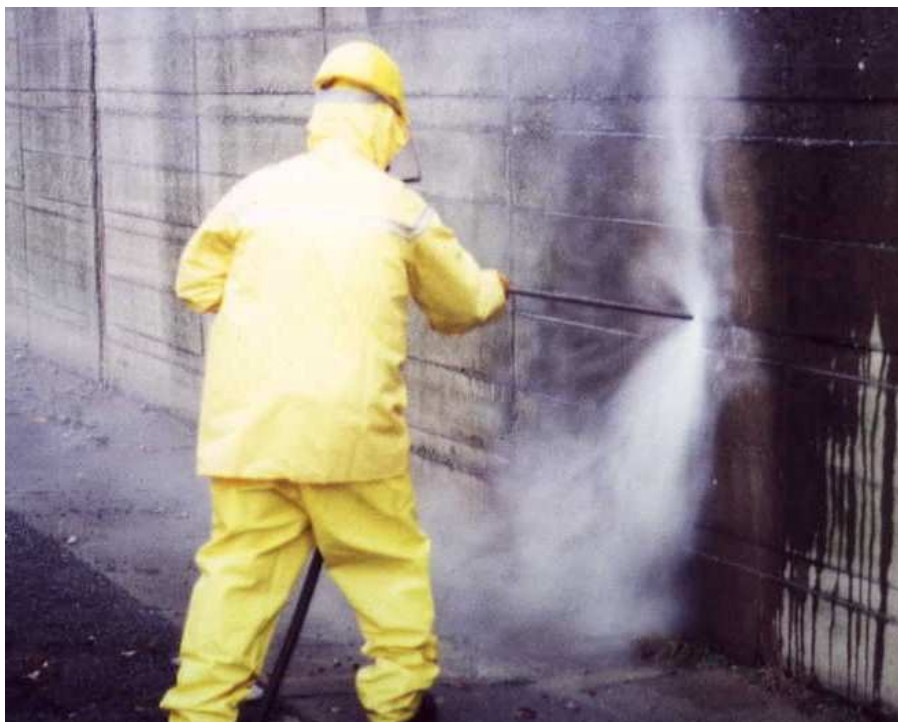
Figura 3.3 – Processo de hidrojetamento de alta pressão numa superfície de concreto.
