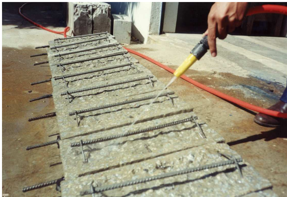
Figura 4.8 – Complementação da limpeza das armaduras com hidrojetamento (TINOCO, 2001).
