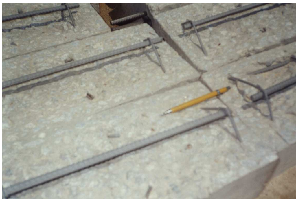
Figura 4.7 - Aspecto das armaduras após o jateamento de areia (TINOCO, 2001).
