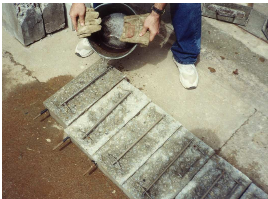
Figura 4.9 – Conclusão da limpeza das armaduras com lavagem com água quente (TINOCO, 2001).
