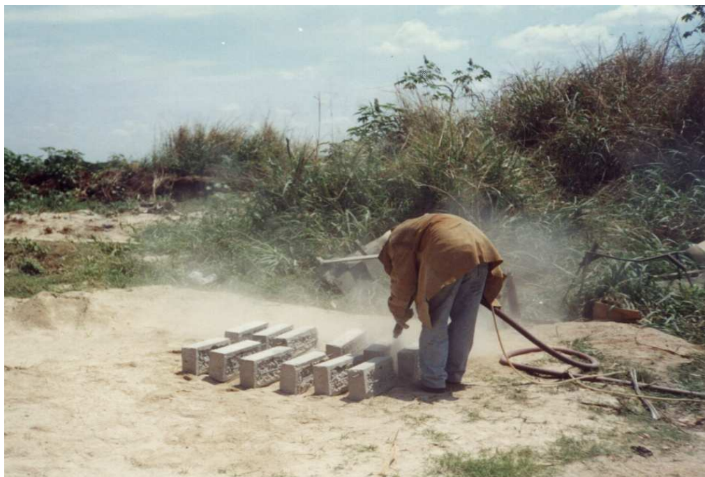
Figura 4.6 – Limpeza das armaduras com jateamento de areia (TINOCO,2001).
