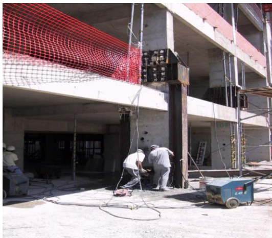
Figura 2.4 Exemplo de sistema de escoramento e demolição de 100% de pilar para substituição de concreto não-conforme. (HELENE, 2003)
