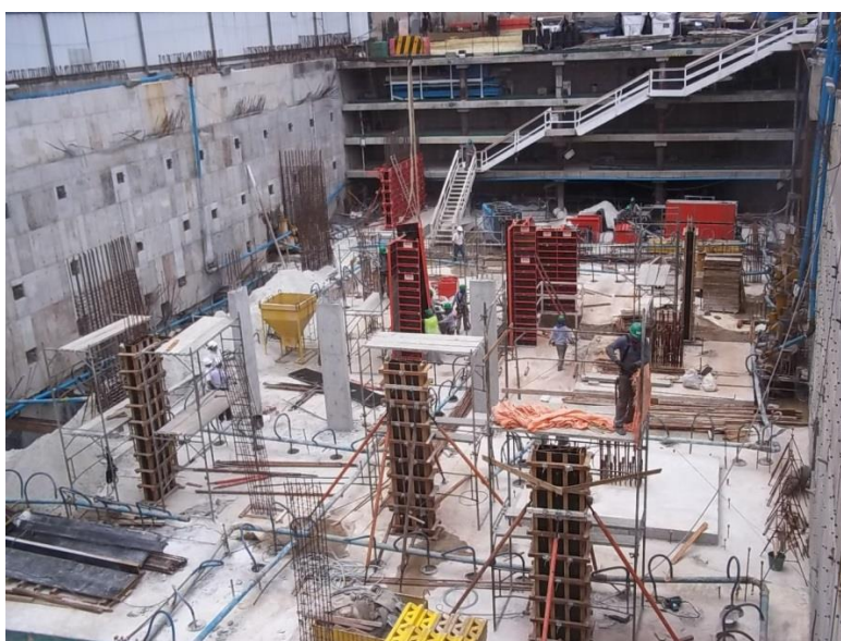
Figura 6 – Laje de subpressão finalizada e início da montagem das fôrmas dos pilares do 2º subsolo (alguns já concretados).
