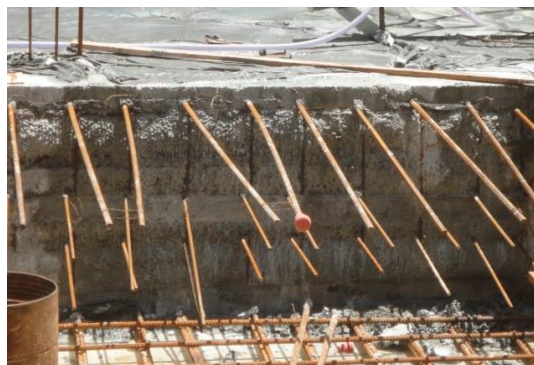
(d) Detalhe da junta de concretagem ainda sem a fita hidro-expansiva: superfície vertical e rugosa, a laje ainda não foi totalmente armada
