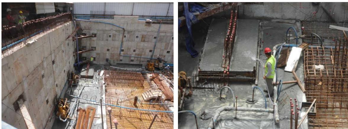
Figura 5- Detalhe de etapa concretada, junto à parede de reforço, com manta de cura disposta na superfície e do procedimento de cura (manta sendo encharcada).
