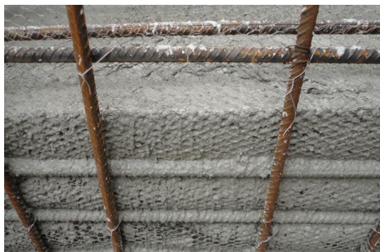
(c) Detalhe do funcionamento da tela de aço galvanizado durante a concretagem: pouca fuga de nata
