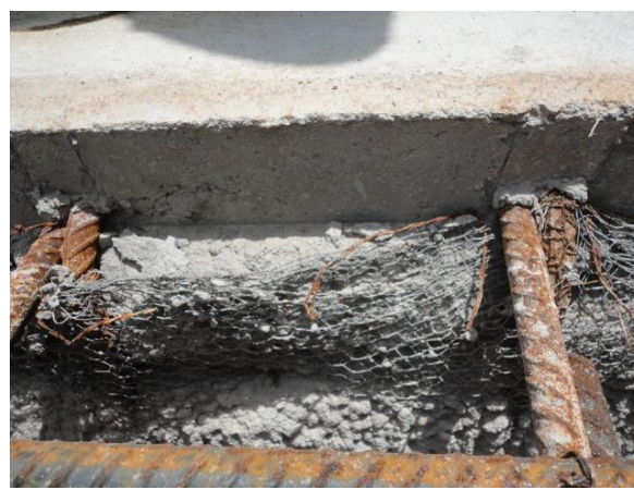
(f) Detalhe do acabamento promovido pelo anteparo superior, a tela remanescente abaixo ainda será cortada
