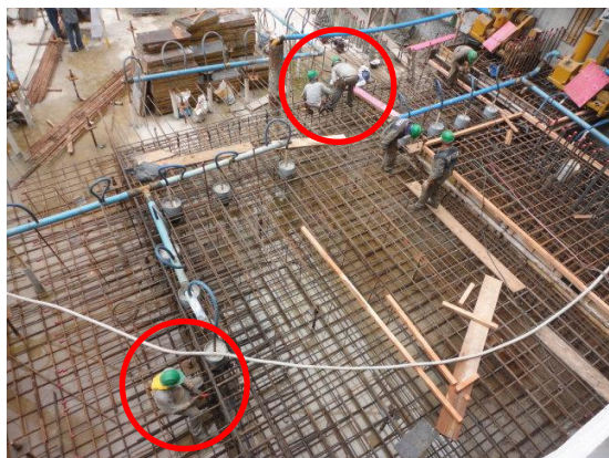
(a) Detalhe de uma das etapas precedentemente a concretagem: ajuste da tela de aço galvanizada na junta prevista
