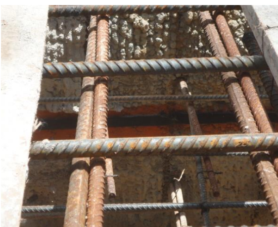
(e) Detalhe da fita hidro-expansiva flexível já instalada para o procedimento de concretagem: a etapa a ser concretada já está totalmente armada
