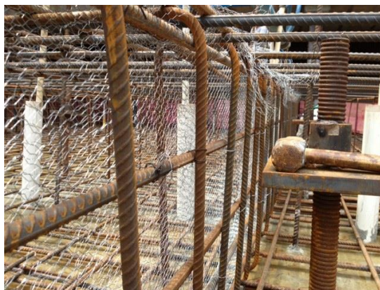
(b) Detalhe da junta de concretagem com uso de tela de aço galvanizada e da armadura de anteparo pela parte externa
