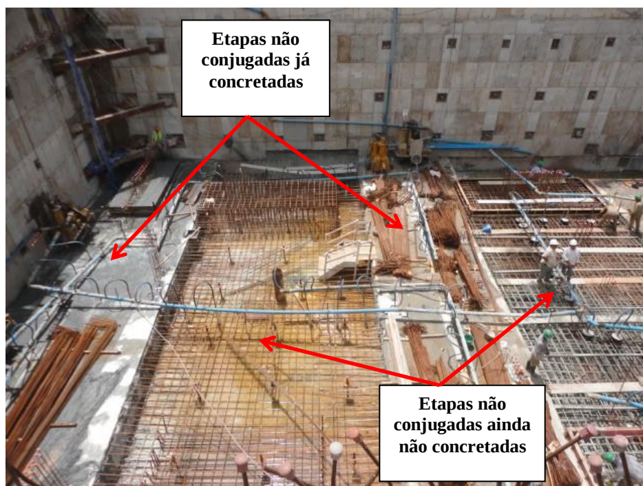
Figura 4 - Etapas de concretagem não conjugadas (faixas intercaladas).
