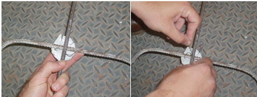
Figura 2.12 – Posicionamento da pastilha no cruzamento das barras.
