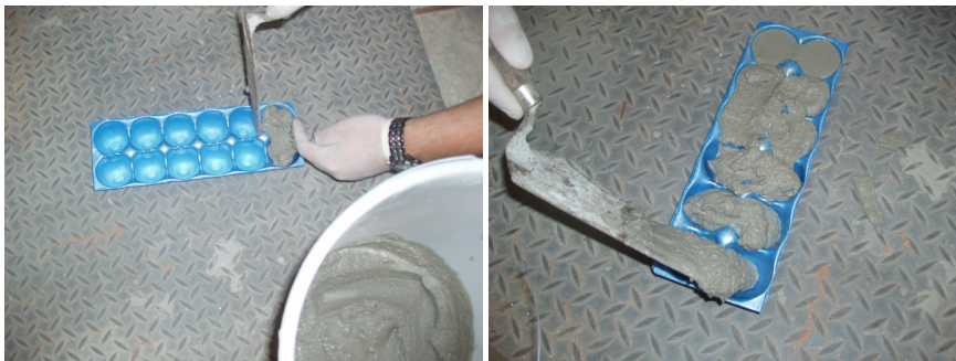
Figura 2.7 – Lançamento da argamassa na fôrma
