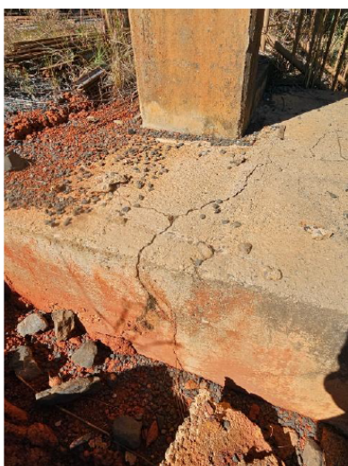
Fotos 6 e 7: Vista geral e em detalhe do estado de fissuração do Bloco B24
