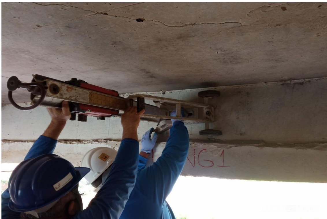
Figura 3.7: Instalação de extratora de concreto na Longarina 1 (SMO, 2022).
