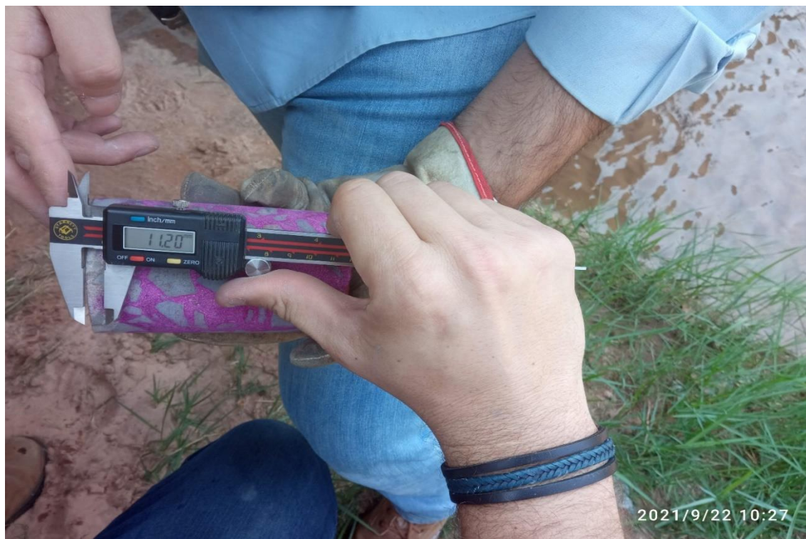
Figura 2.12: Aferição de profundidade de carbonatação em testemunho (SMO, 2022).
