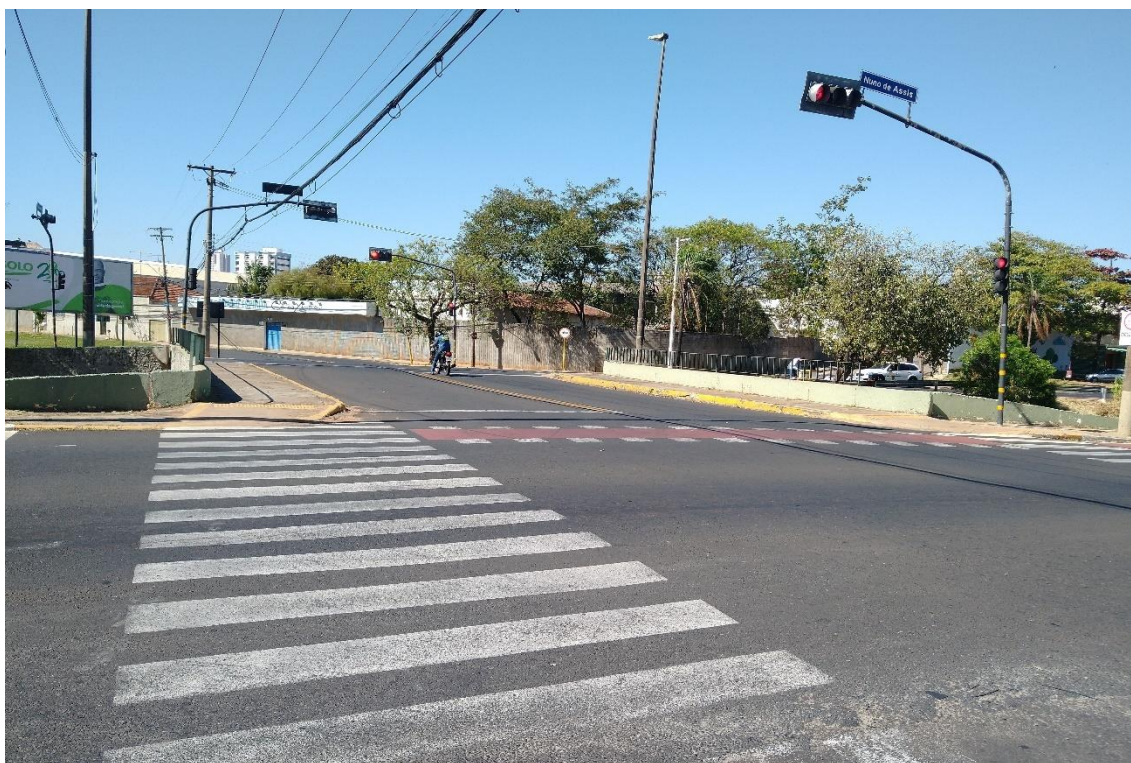
Figura 3.4: Vista geral da ponte, lado Bairro (SMO, 2022).
