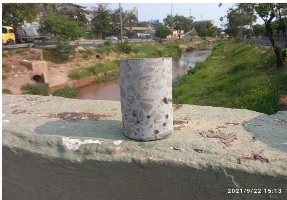
Figura 3.14: Após retirada do testemunho da estrutura, aguardou-se a secagem do mesmo para posterior ensaio de carbonatação (SMO, 2022).
