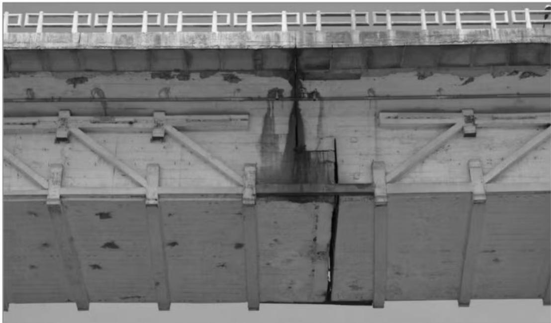
**Figura 2.6** – Meio do vão de 140m, detalhe da protensão externa na parte inferior
