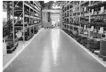
Proteção superficial de concreto
