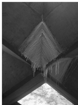
Cobertura do Prédio da FAU-USP
