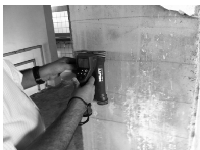
Pacometria de pilares para locação de armaduras
