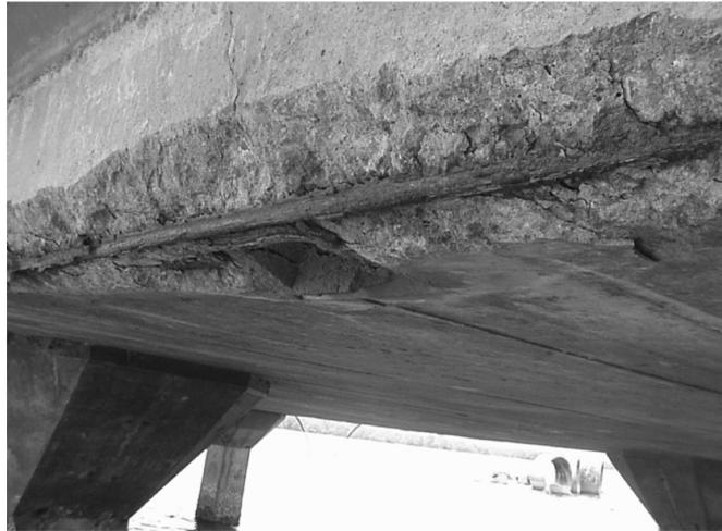
O deterioro precoce da armadura se apresenta frequentemente devido à elevada instabilidade do aço frente a ambientes agressivos
