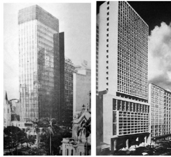
Edifício Wilton Paes de Almeida (fig.80) e Edifício Bolsa de Cereais (fig.81)
