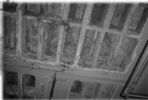
Laje de cobertura
