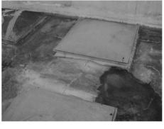
sistema de impermeabilização rompido em diversos pontos
