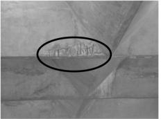
presença de corrosão de armaduras
