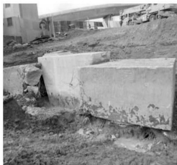
Na imagem, pilar do Batalha dos Guararapes afundado sobre o bloco que se rompeu
