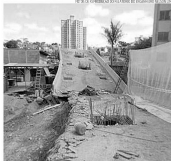
Aberturas são feitas para, durante a obra, criar acesso à parte inferior do tabuleiro
