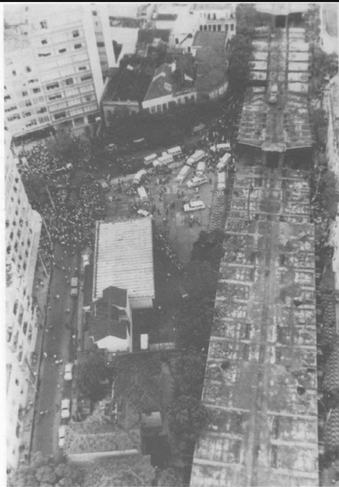
Desabamento do elevador Paulo de Frontin em 1971 — O Globo
