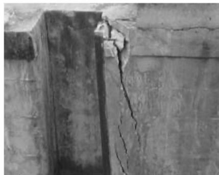
(b) fissura secundárias na guia da comporta da tomada d'água da UHE Paulo Afonso I
