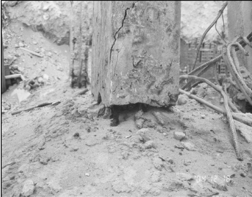
Ligação pilar - sapata com redução da seção transversal do pilar
