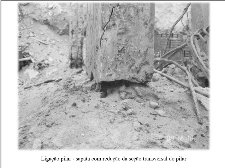
Ligação pilar - sapata com redução da seção transversal do pilar
