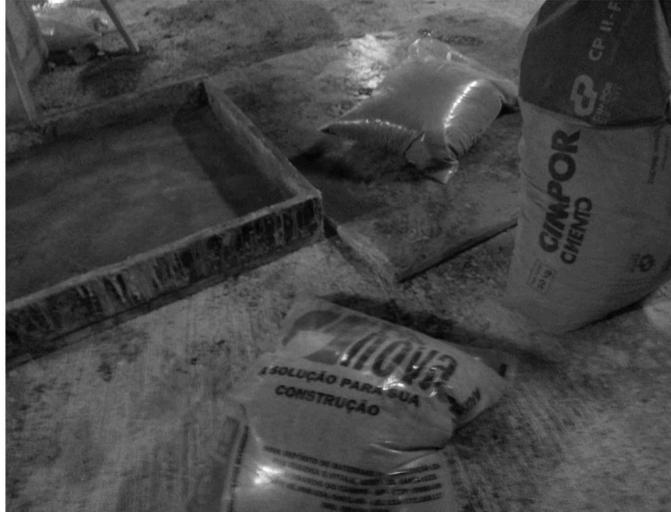
Todo reparo estrutural deve ser realizado com argamassa, graute ou concreto com resistência bem superior à da peça. No mínimo igual.
