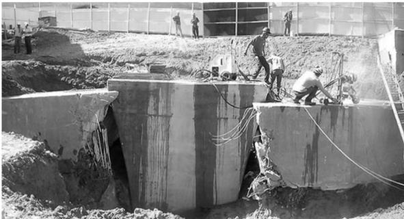
O pilar P3, que afundou pelo meio do bloco devido a dimensões inadequadas, segundo aponta laudo do Instituto de Criminalística
