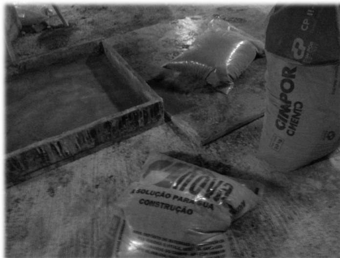
Todo reparo estrutural deve ser realizado com argamassa, graute ou concreto com resistência bem superior à da peça. No mínimo igual.
