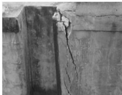
(b) fissura secundárias na guia da comporta da tomada d'água da UHE Paulo Afonso I
