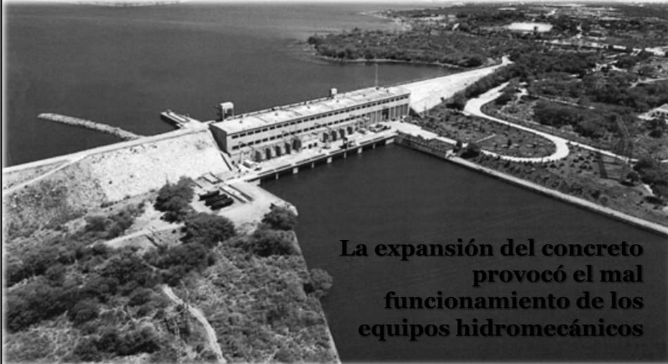
La expansión del concreto provocó el mal funcionamiento de los equipos hidromecánicos
