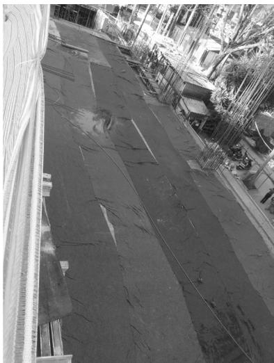
Após o endurecimento do concreto inicial (perceptível ao tato), cobrir o local com manta encharcada de água mantida pressionada sobre toda a superfície concretada e, manter saturada a cada 2h
