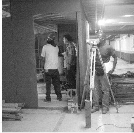
Controle contínuo de deslocamento vertical (recalque) dos pilares P1, P1A e P2
