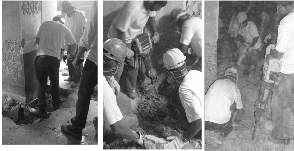
Demolição Piso fase 1
