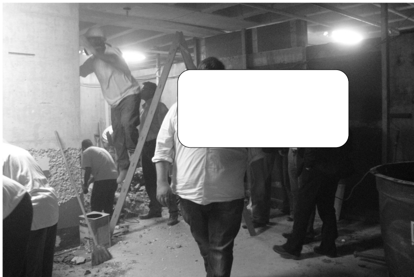
Escavação Piso fase 1
