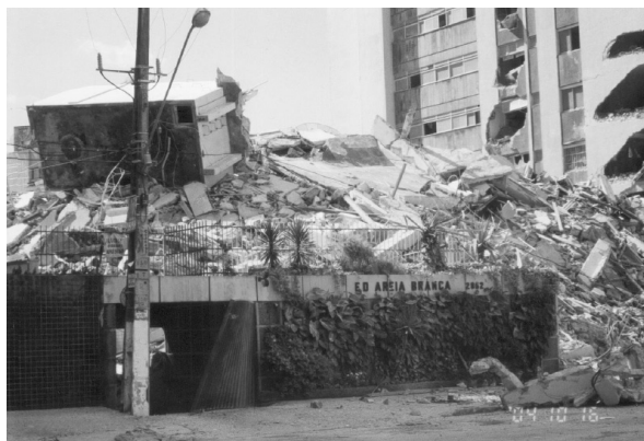
Escombros - manhã seguinte do desabamento
