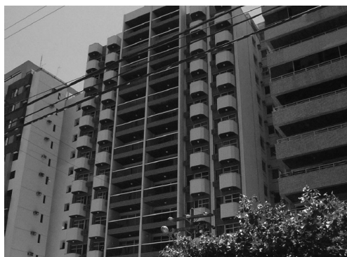
EDIFÍCIO AREIA BRANCA – Pernambuco
