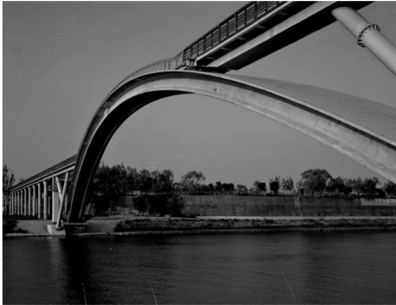
Passarela em Seoul, Coréia
