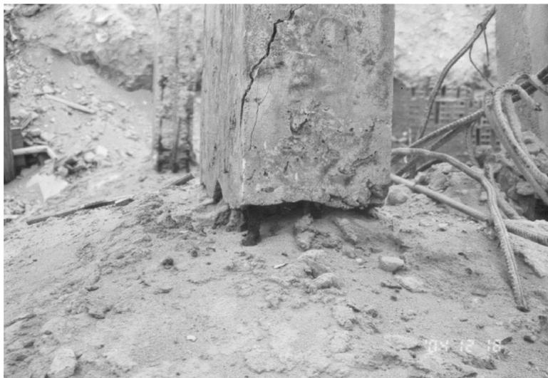
Ligação pilar - sapata com redução da seção transversal do pilar
