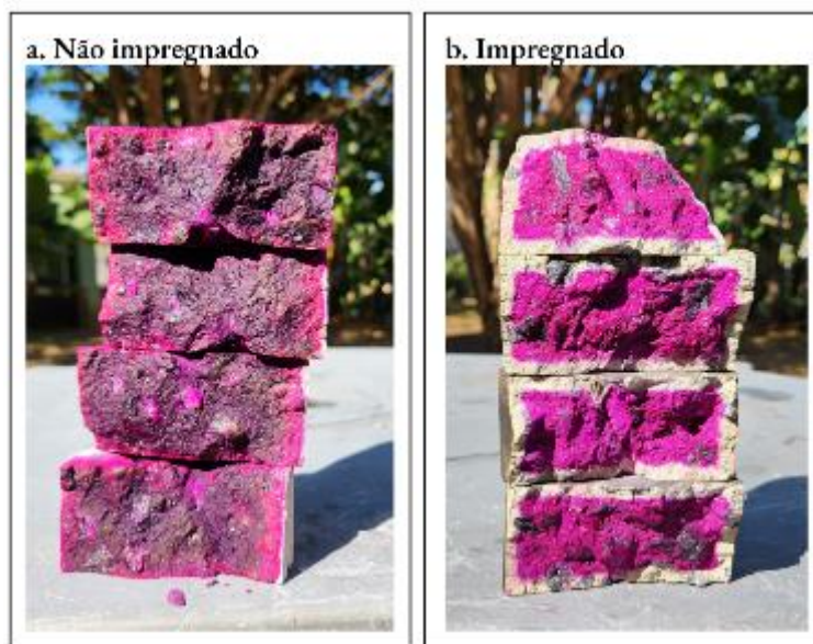
Figura 50 - Área de frente de carbonatação no concreto de traço 0.65 no período de T360.
