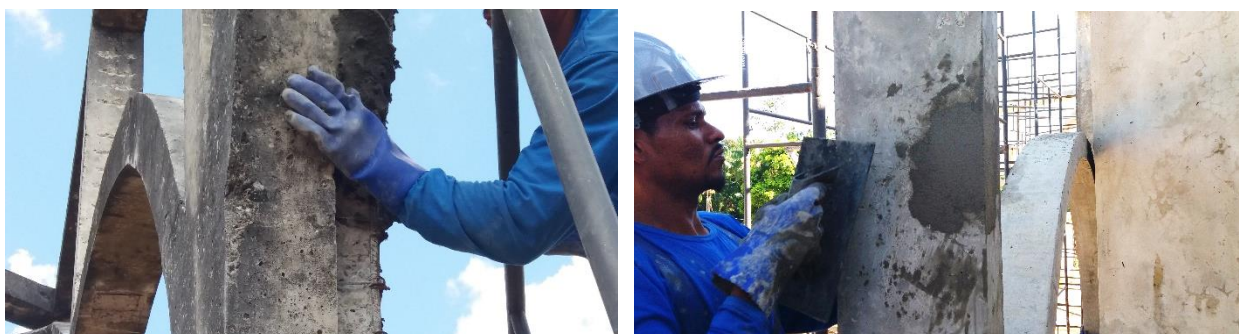
Figura 17. Preenchimento manual da área de reparo e acabamento com desempenadeira.
