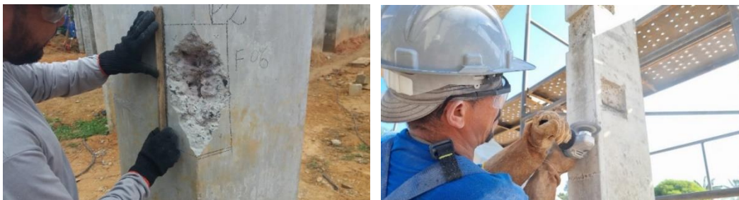
Figura 13. Demarcação e delimitação das áreas de reparo em figuras ou formas geométricas retangulares.
