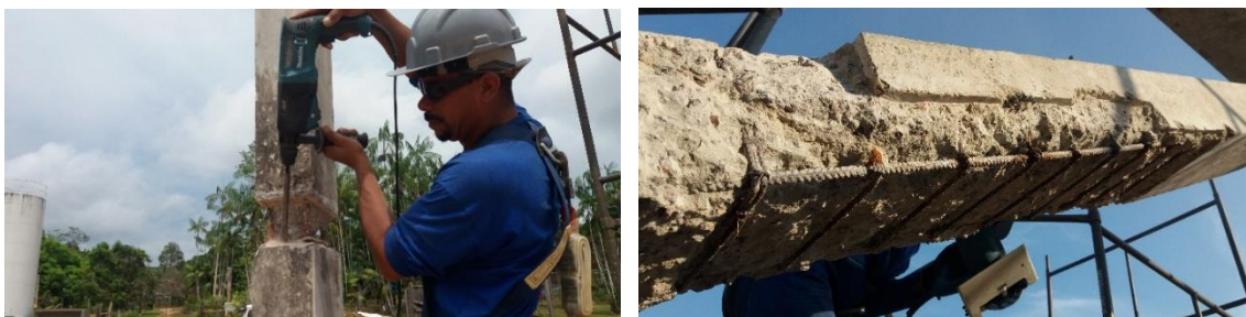
Figura 14. Escarificação do concreto deteriorado, eliminação do material dentro da área delimitada até remoção de todo o material solto e de baixa resistência.
