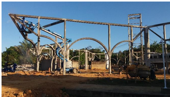
Figura 5. Estrutura de concreto armado, face externa do lado 1B da ala 1.
