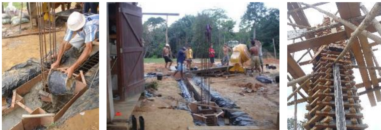
Figura 6. Detalhe da execução da estrutura com mão de obra local, fases 1 e 2. (fonte: ICEFLU)
