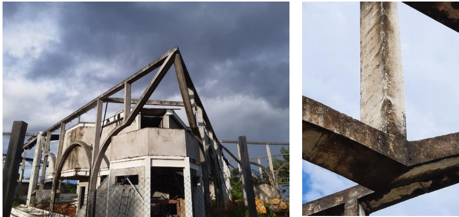
Figura 7. Visão geral da estrutura em dezembro de 2021.
