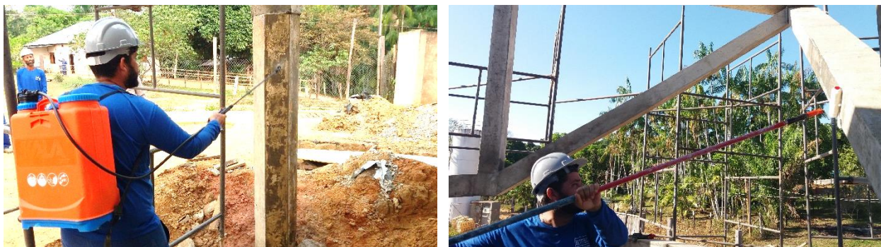
Figura 20. Aplicação do silicone hidrorrepelente empregando pulverizador costal e rolo de espuma, duas demãos.
