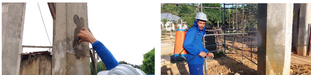
Figura 18. Estucamento e tamponamento de bolhas superficiais e cura úmida com pulverizador costal.
