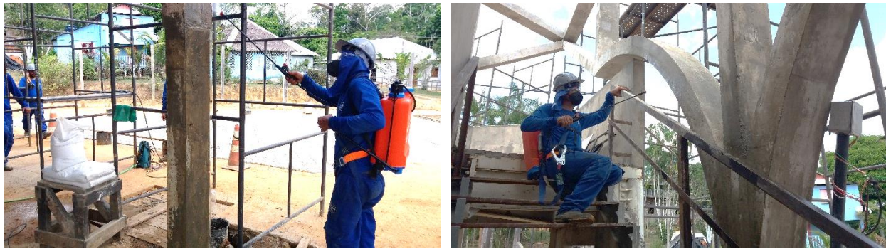
Figura 19. Aplicação do inibidor de corrosão empregando pulverizador costal.
