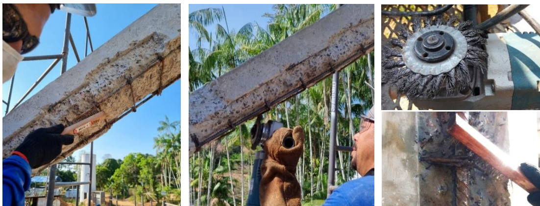
Figura 15. Limpeza das armaduras, remoção dos produtos de corrosão formados na superfície das armaduras. Limpeza com escova de aço manual e escova de aço acoplada a uma esmerilhadeira.
