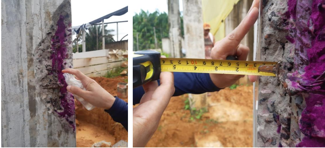
Figura 10. Detalhe do ensaio de carbonatação e verificação do cobrimento.
