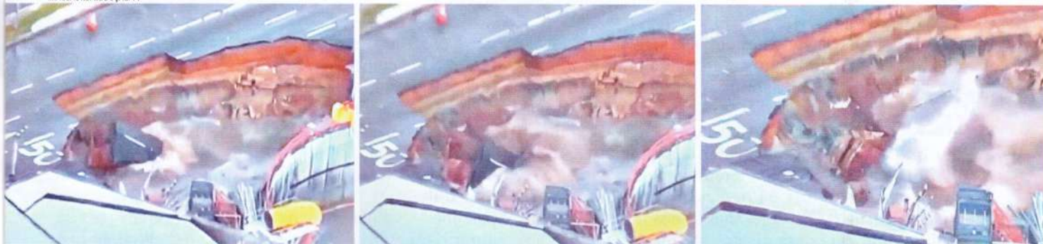
Colapso da pista local da Marginal Tietê, no sentido da Rodovia Ayrton Senna, na tarde do acidente: sem previsão para a liberação
