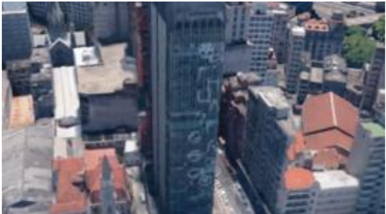
O antes e depois do prédio que pegou fogo e desabou em São Paulo
