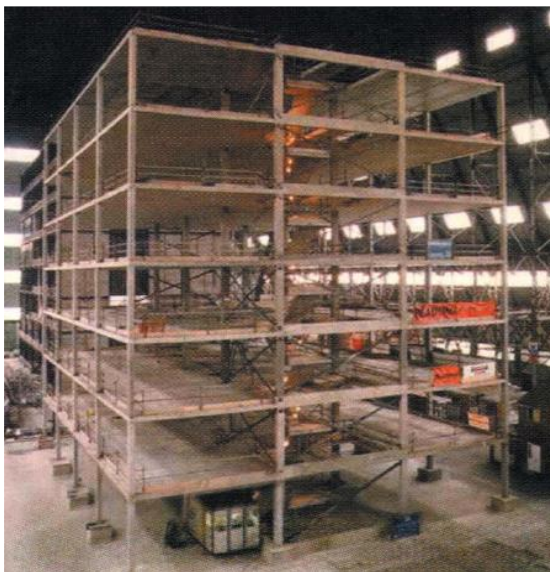
Figura 16. Perspectiva da estrutura protótipo em concreto armado concebida para o experimento de simulação de incêndio em Cardington (Chana & Price, 2003).
