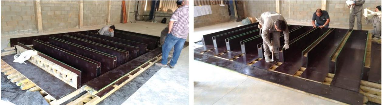
**Figura 12** – Montagem das fôrmas de base e das laterais dos elementos.
