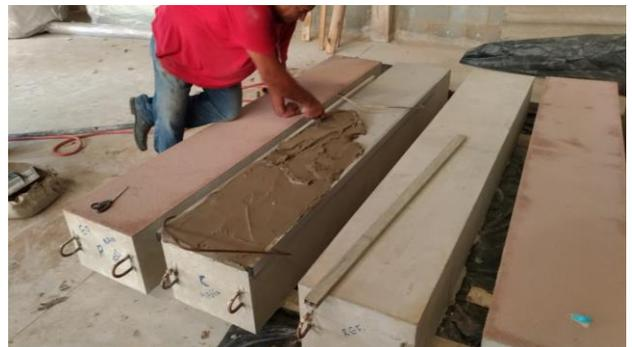
**Figura 40** – Detalhe da preparação e aplicação da argamassa industrializada base cimento, aplicada após 15 dias do chapisco desempenado.
