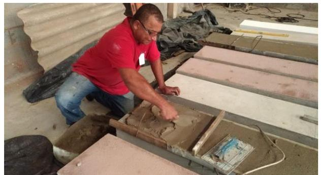
**Figura 41** – Detalhe da preparação e aplicação da argamassa industrializada base cimento, aplicada após 15 dias do chapisco desempenado.
