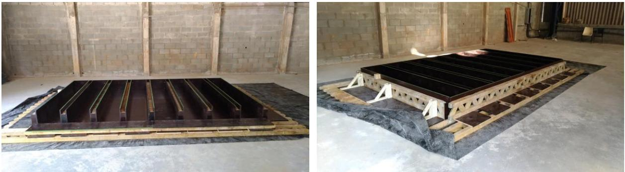
**Figura 13** – Fôrmas dos oito elementos completamente montadas.
