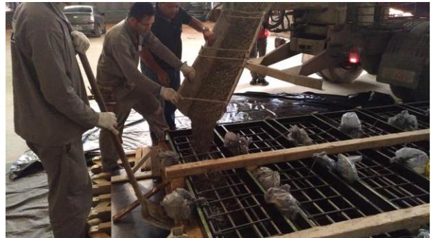
**Figura 23** – Detalhe do posicionamento da bica e do início do lançamento do concreto.
