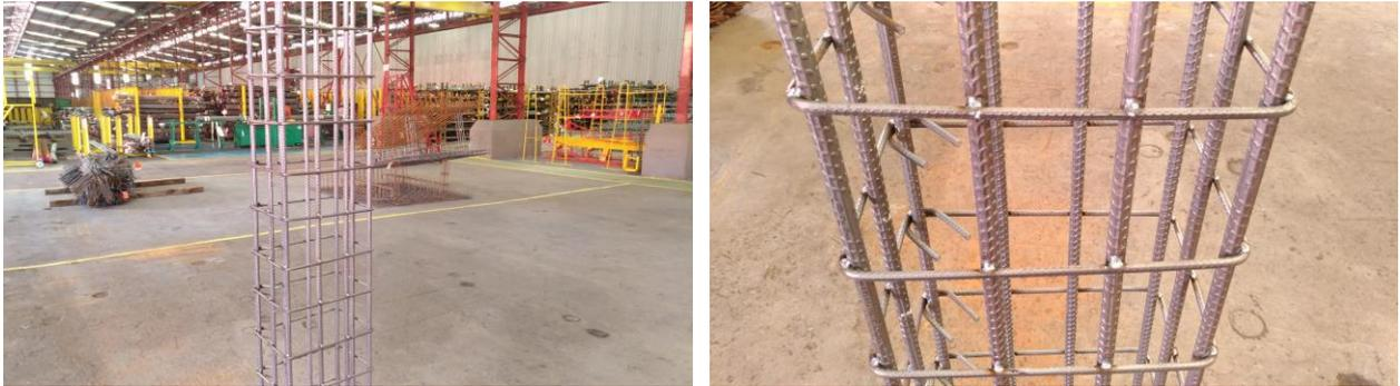
**Figura 10** – Detalhe da armadura e dos estribos soldados junto à armadura longitudinal.
