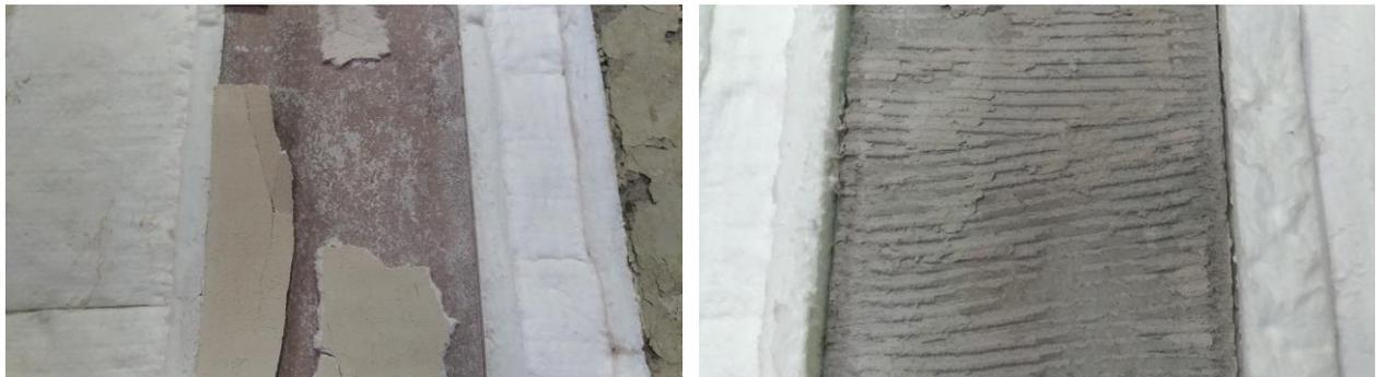
**Figura 56** – Detalhe do chapisco rolado e do chapisco desempenado, totalmente íntegros na amostra com revestimento de gesso formulado liso e argamassa industrializada base cimento.
