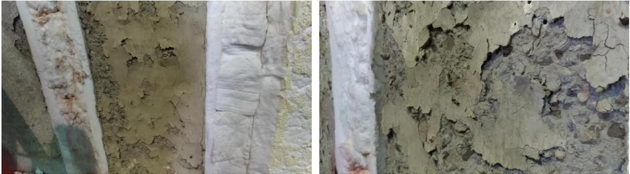
**Figura 75** – Detalhe do deslocamento típico ocorrido na amostra de referência.
