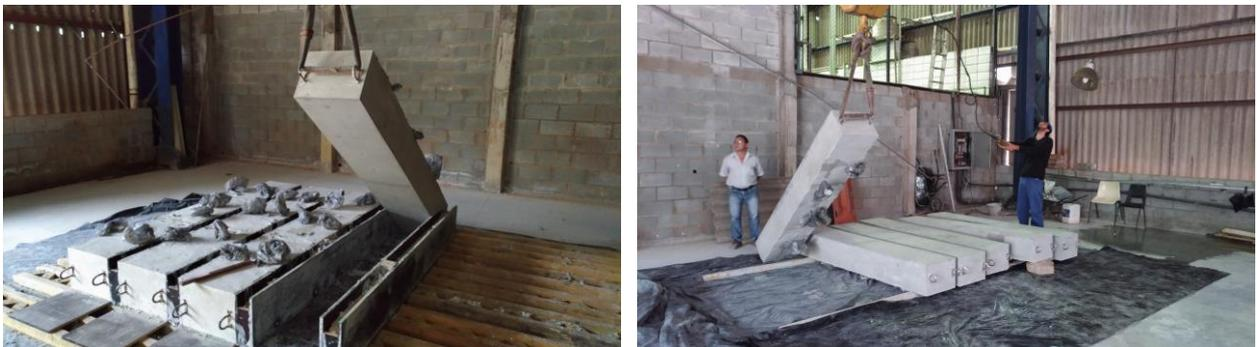
**Figura 31** – Detalhe de içamento (para desfôrma, à esquerda) e giro para posicionamento com a inversão da face (à direita), com uso de sistema de ponte rolante.
