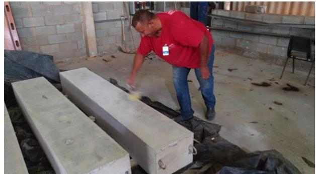
**Figura 34** – Detalhe de lixamento leve (lixa ferro n. 36 da Norton) e limpeza da poeira com uso de pincel de cerdas macias, precedentemente aos preparos dos substratos (limpeza inicial das superfícies).
