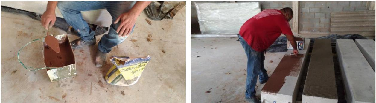
**Figura 38** – Detalhe do preparo do chapisco (coloração terracota) e de sua aplicação na amostra que receberá o revestimento base gesso / manual e projetado (chapisco rolado).
