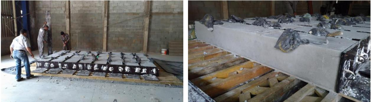
**Figura 29** – Início da desfôrma dos elementos (aproximadamente dez dias após a construção) e detalhe da boa qualidade da face lateral do elemento (evidenciando um concreto bem lançado e adensado).
