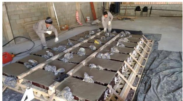
**Figura 25** – Detalhe do adensamento e acabamento do concreto.
