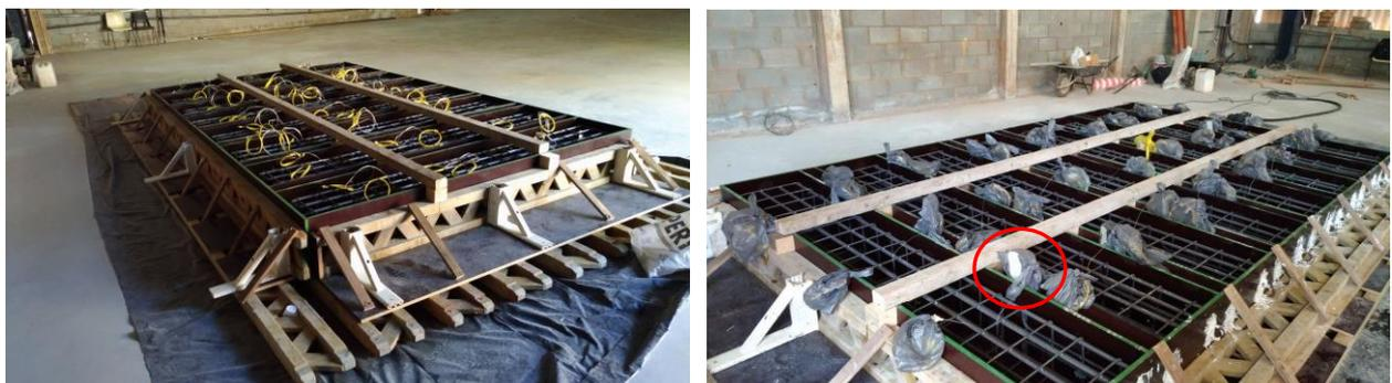
**Figura 20** – Armaduras já dispostas com espaçadores e termopares fixados (sacos plásticos com fitas crepes indicam os termopares com profundidade de leitura no eixo da amostra).
