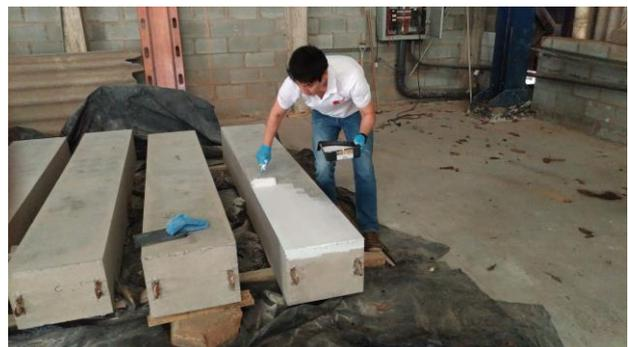
**Figura 35** – Detalhe da aplicação da primeira demão de tinta intumescente, sem fundo preparador ou ponte de aderência, conforme orientações do fornecedor do produto.
