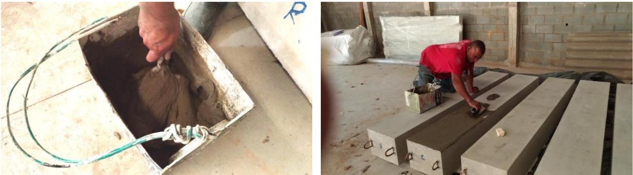
**Figura 37** – Detalhe do preparo do chapisco (coloração acinzentada) e de sua aplicação na amostra que receberá o revestimento base cimento / argamassa industrializada (chapisco desempenado, dente de 8 mm x 8 mm).
