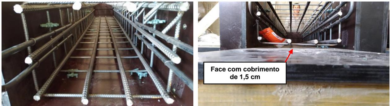
**Figura 19** – Detalhe da armadura disposta no interior da fôrma para ajustes de alinhamentos (ainda sem espaçador fixado/amarrado) e face onde o cobrimento será de 1,5cm (base).
