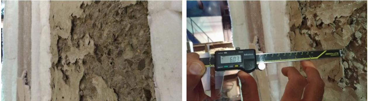
**Figura 59** – Detalhe do deslocamento típico em 19% da amostra, com profundidade aferida da ordem de 6 mm, com uso de paquímetro digital.
