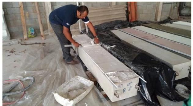
**Figura 45** – Detalhe da aplicação e do acabamento do gesso projetado.
