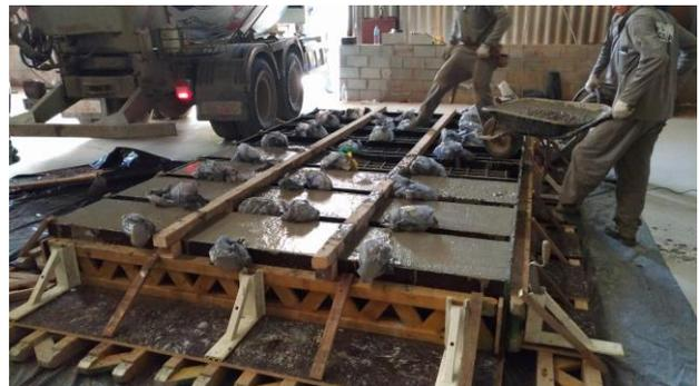
**Figura 24** – Detalhe do lançamento e adensamento do concreto.
