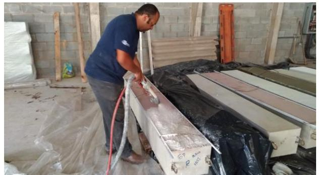
**Figura 44** – Detalhe da máquina de projeção m-tec M280 e da aplicação do gesso projetado.
