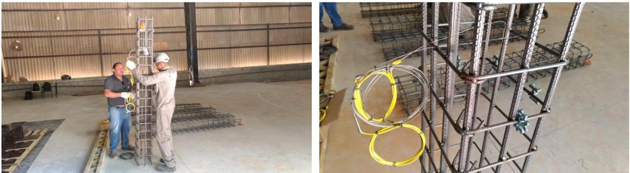
**Figura 14** – Detalhe da instalação dos termopares em profundidades e cotas distintas.
