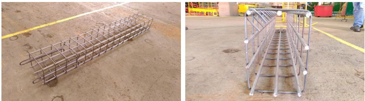
**Figura 9** – Detalhe das armaduras e ganchos das amostras.
