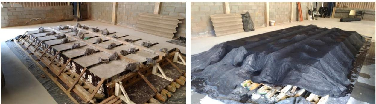
**Figura 28** – Detalhe dos elementos no dia seguinte à concretagem e início dos procedimentos de cura (com manta encharcada com água).
