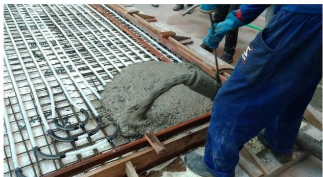
Figura 7 – Detalhe do ensaio de espalhamento e lançamento do concreto autoadensável.
