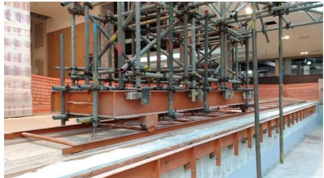
Figura 6 – Detalhe do Rink de patinação e da passarela móvel acoplada nas laterais por dois carrinhos deslizantes sobre trilhos (dois jogos, também móveis, orientados por uma guia).
