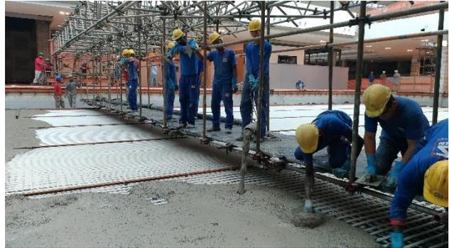
Figura 8 – Detalhes do lançamento, espalhamento e acabamento do concreto.
