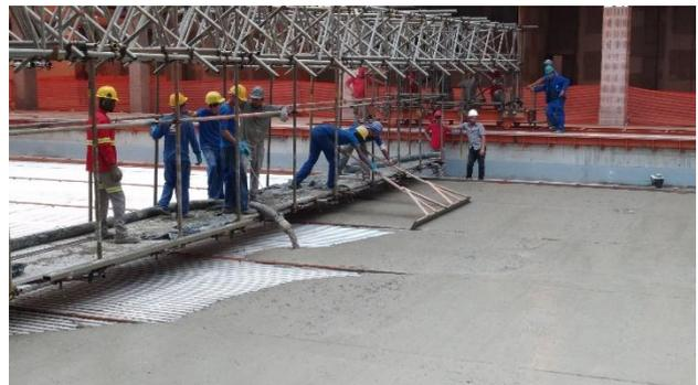
Figura 9 – Detalhes do lançamento e espalhamento do concreto.
