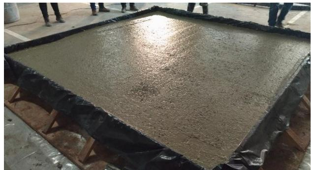
Figura 5 – Lançamento concreto envolvendo bem as serpentinas e protótipo já finalizado.
