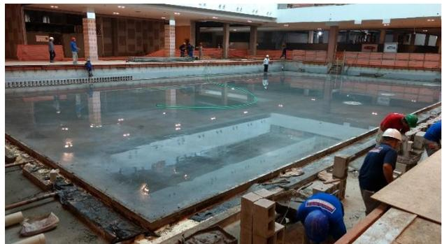
Figura 10 – Detalhe do Rink de patinação finalizado e da cura realizada no dia seguinte.
