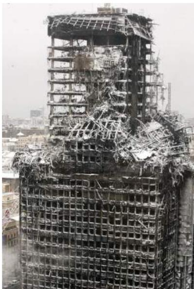
Figura 7.17. Fachada no pós-incêndio (Fonte: Art Chist<sup>50</sup>)
