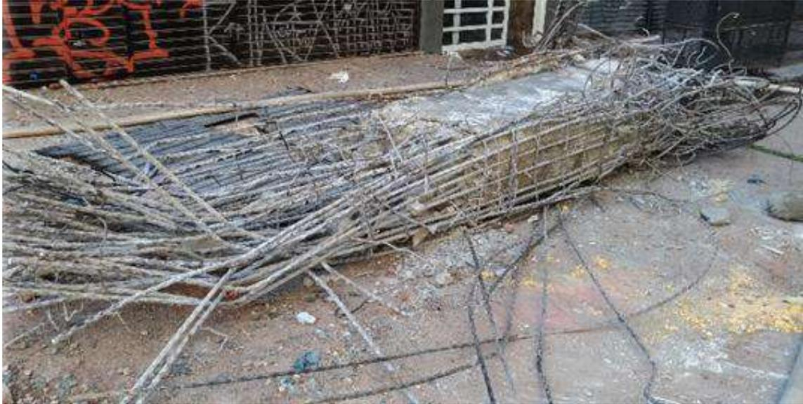
Figura 7. Remoção das barras de aço excedentes.
