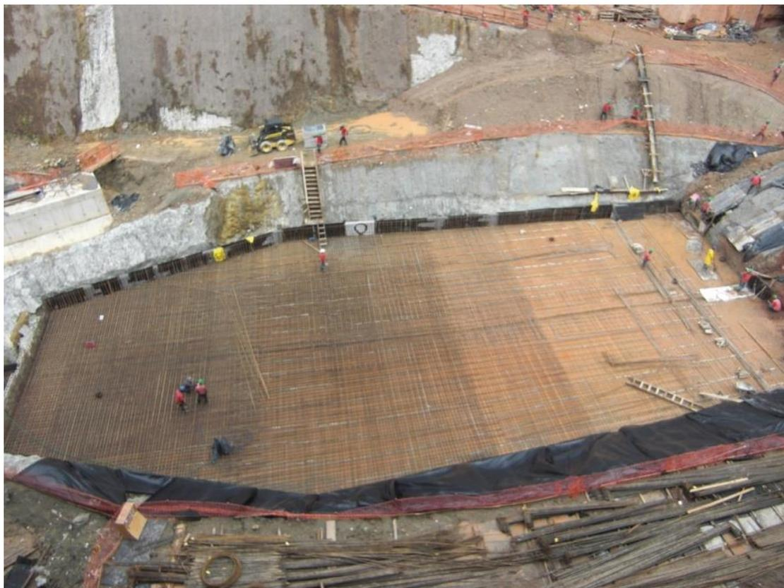
Figura 1.4 Sapata única de fundação do Ed. Infinity Tower em São Paulo, SP.
