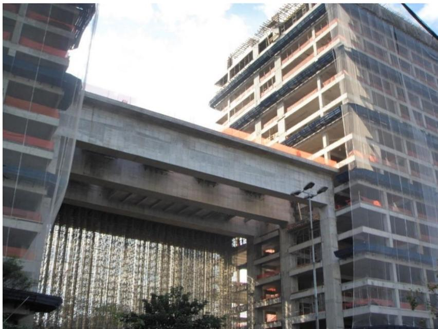
Figura 1.2 Edifício Pátio Victor Malzoni, em São Paulo, SP – Vigas de transição em concreto protendido, com volume de cerca de 800 m<sup>3</sup>.
