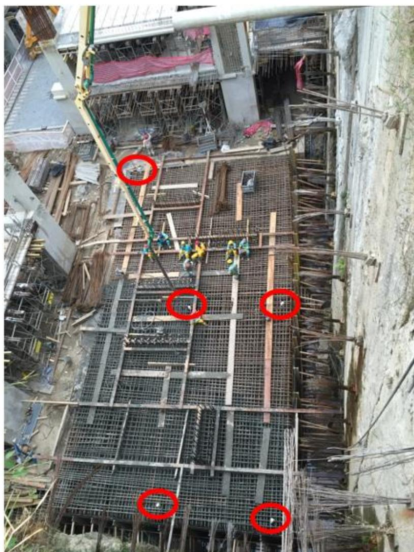
Figura 6.32 Sapata armada, precedente a concretagem da primeira camada, e termopares destacados em vermelho.
