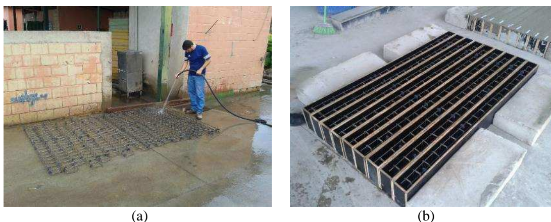
Figura 3.6 – Preparação das armaduras e das formas: (a) limpeza das armaduras; (b) aspecto geral das formas.
