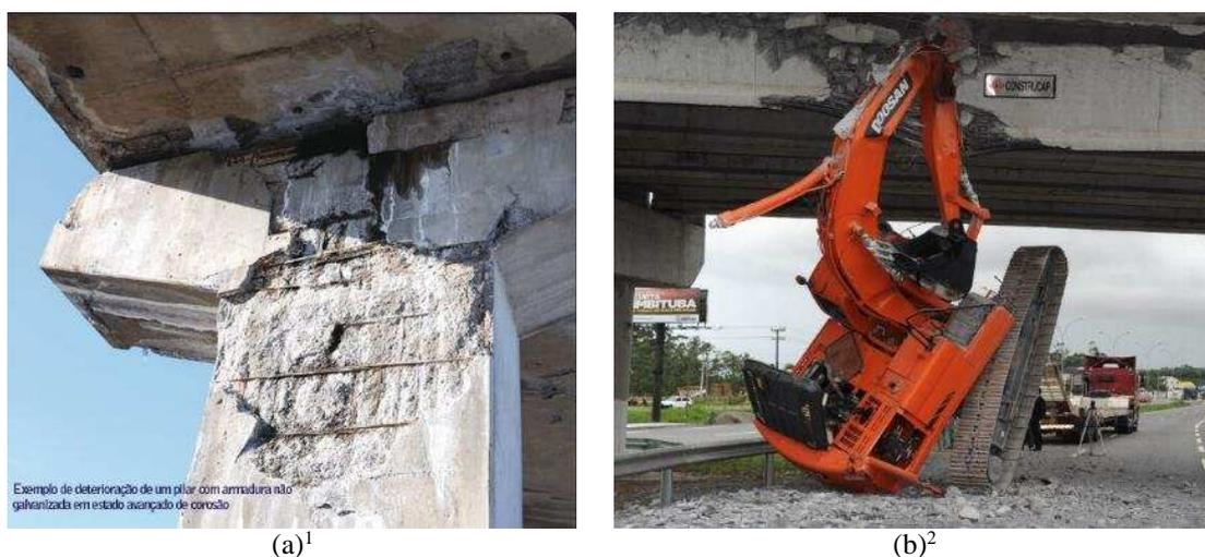
**Figura 1-1 – Exemplos de deterioração de estruturas de concreto armado: (a) fissuração e corrosão de armaduras; (b) perda de massa devido a impacto de veículo.**
