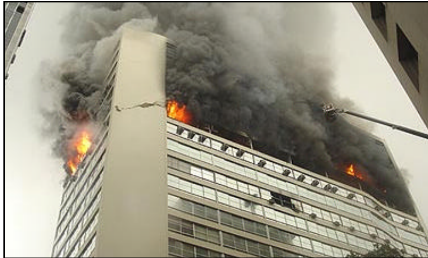
Figura 2.2 - Incêndio no prédio da Eletrobrás, Rio de Janeiro
