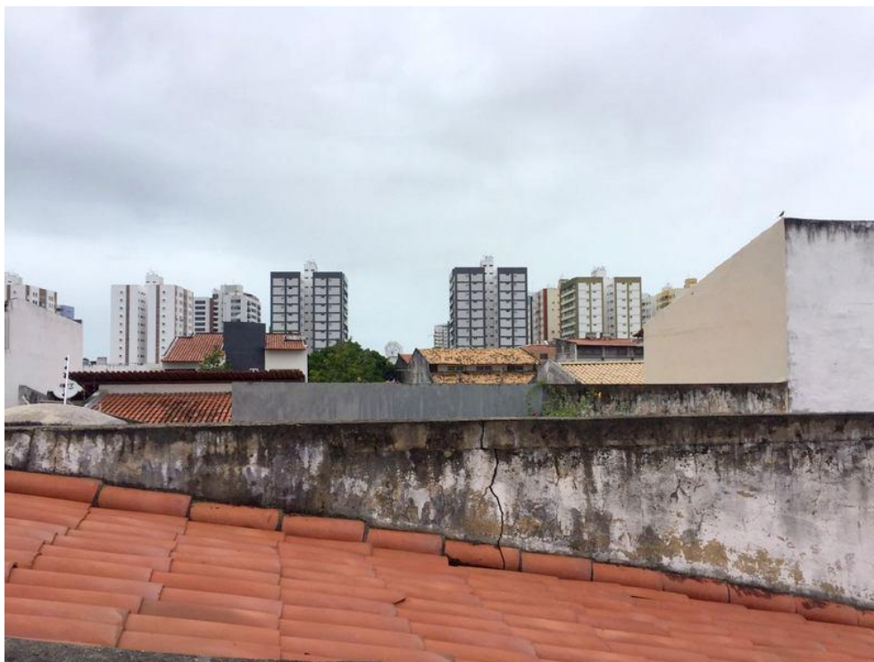
Figura 56 - Vista dos prédios da estação E2
