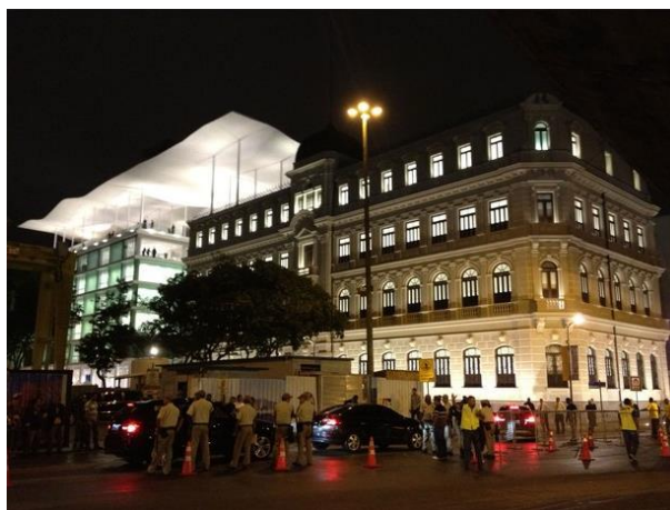
Figura 4 – Concreto autocicatrizante da cobertura fluida do Museu de Arte do Rio - M.A.R. - RJ (Foto do autor).
