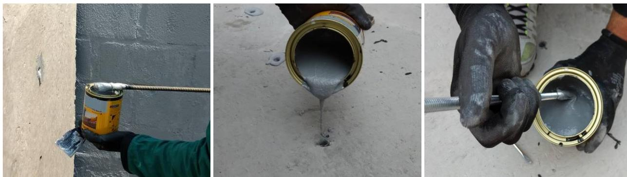
Figura 7 - Procedimento de aplicação do produto B (adesivo).
