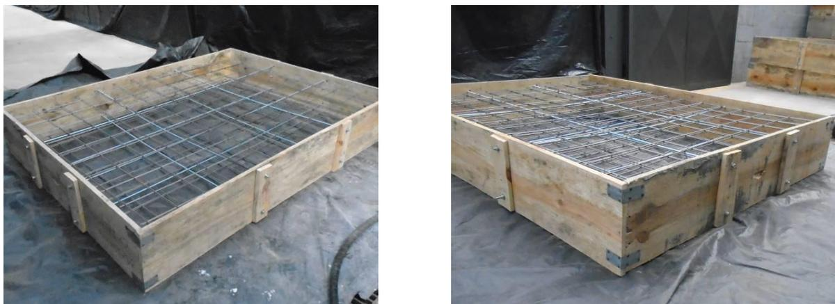
Figura 3 – Detalhe da fôrma da placa de concreto
