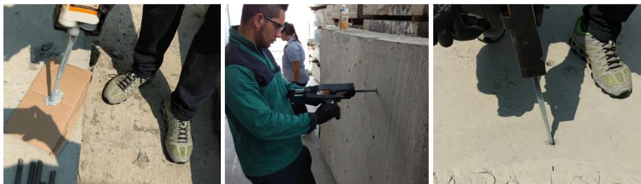
Figura 6 - Procedimento de aplicação do produto A (injeção).
