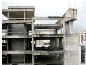
FOTO 4 - MANCHAS ESCURAS DA IMPREGNAÇÃO DE FULIGENS E PROLIFERAÇÃO DE MICRO-ORGANISMOS NA SUPERFÍCIE DO CONCRETO APARENTE DA ESTRUTURA INACABADA EM OBRA NA CIDADE DE SÃO PAULO FONTE: ARQUIVO PESSOAL DO AUTOR (TOMAZELI, 2015, P. 145)
