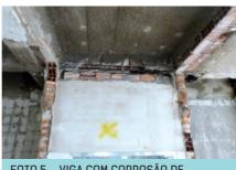
FOTO 5 – VIGA COM CORROSÃO DE ARMADURAS
