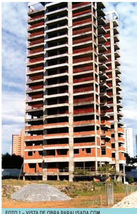
FOTO 1 - VISTA DE OBRA PARALISADA COM ESTRUTURA À VISTA. FONTE: ARQUIVO PESSOAL DO AUTOR (TOMAZELI, 2004, P. 05)
