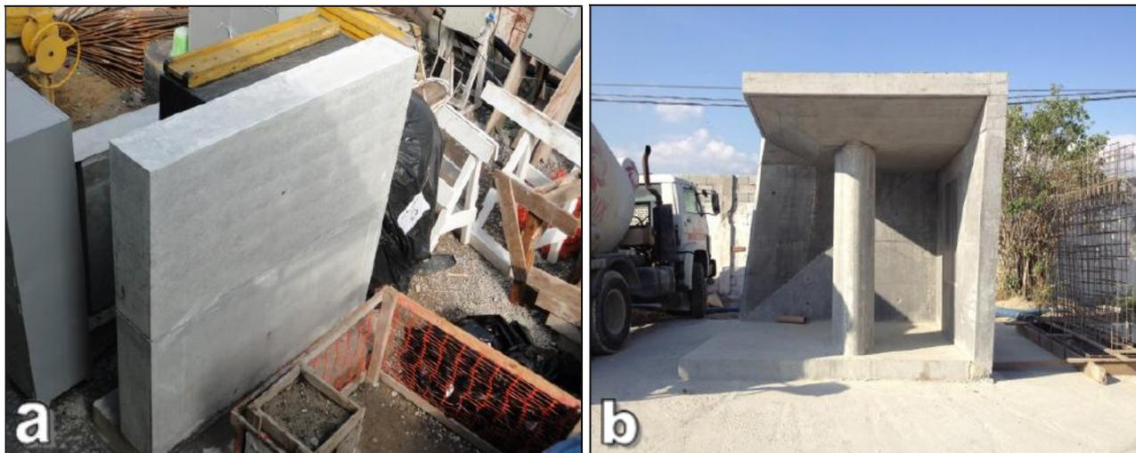
Figura 3 – (a) Detalhe do protótipo da parede vertical e (b) exemplo do protótipo com elementos inclinados
