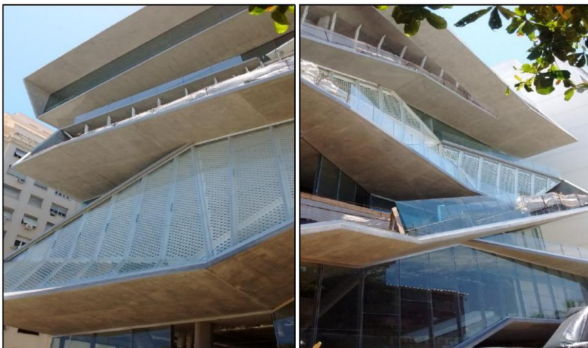
Figura 8 – Resultado final do bom acabamento do concreto em outros pontos da estrutura.
