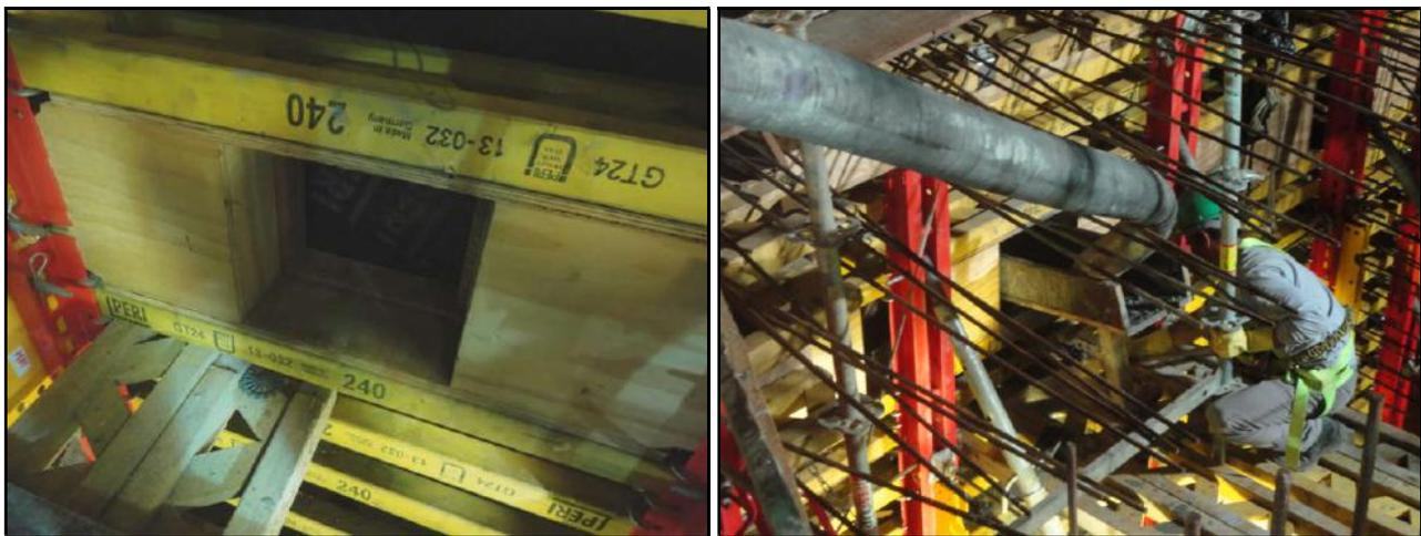
Figura 6 – Detalhe da janela do primeiro nível de concretagem já tampada e do concreto sendo lançado do segundo nível (região da inclinação/dobra) da PAR 18.
