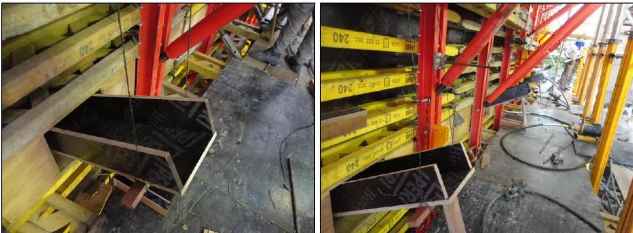
Figura 4 – Detalhe do cachimbo removível e dos vários cachimbos dispostos ao longo da parede PAR 18 (primeiro nível).
