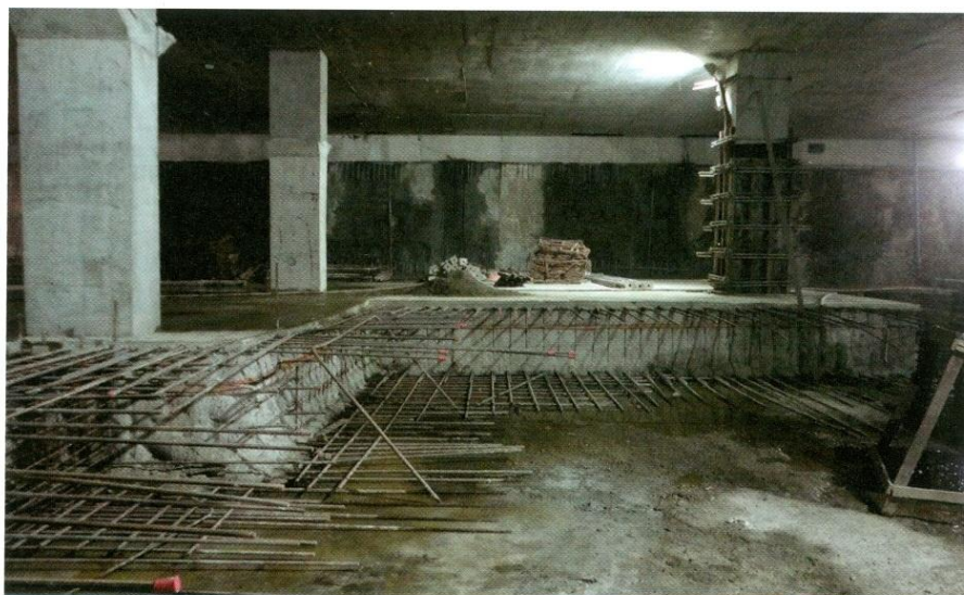
FIGURA 4 – PARTE DE LAJE DE SUBPRESSÃO CONCRETADA, OBRA HOSPITAL COPASTAR SITO EM COPACABANA/RJ.
