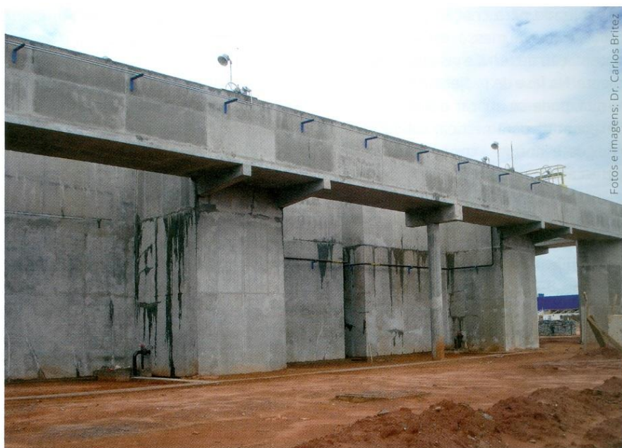
FIGURA 1 – PROBLEMAS DE ESTANQUEIDADE EM ESTRUTURA DE CONCRETO ARMADO (EM JUNTAS E FISSURAS)
