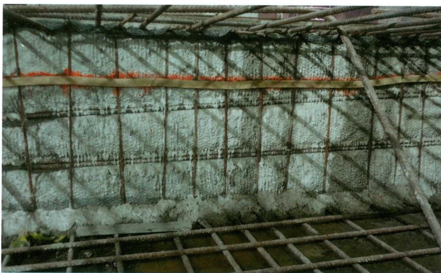
FIGURA 5 – DETALHE DA JUNTA JÁ PREPARADA COM A FITA HIDROEXPANSIVA POSICIONADA PARA POSTERIOR CONCRETAGEM, DA ETAPA SUBSEQUENTE.
