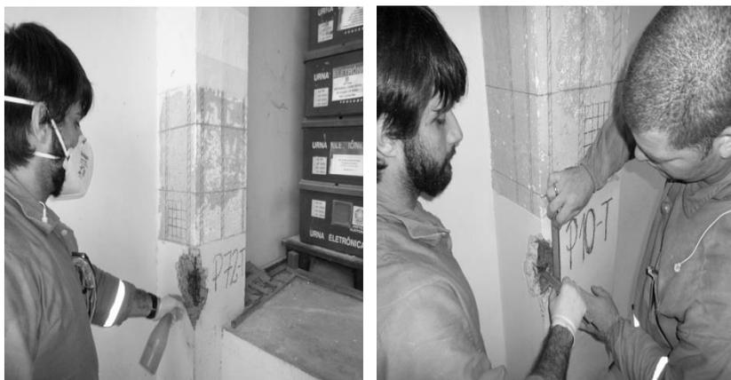
Figura 3.2: Aspersão de solução de fenolftaleína para medição da profundidade de carbonatação e verificação das espessuras carbonatadas.
