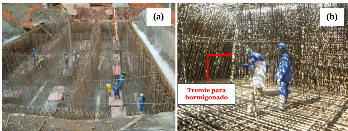
Figura 11. (a) Hormigonado de la segunda capa sin la armadura superior y (b) hormigonado después de haber colocado toda la armadura.
