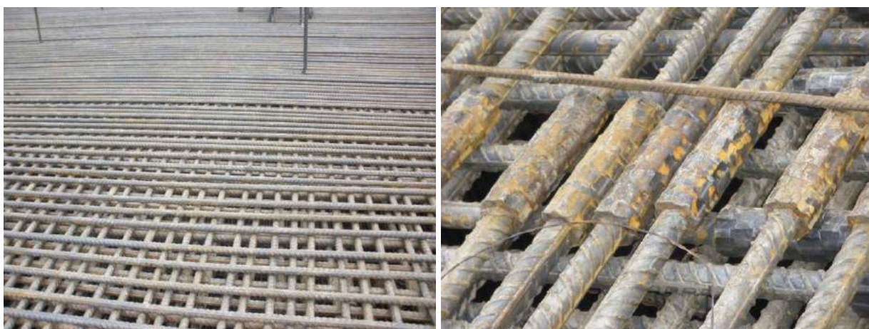
Figura 12. La armadura superior consistía en dos capas dobles de barras de 32mm. El hormigón HAC se diseñó para pasar a través de esta armadura.
