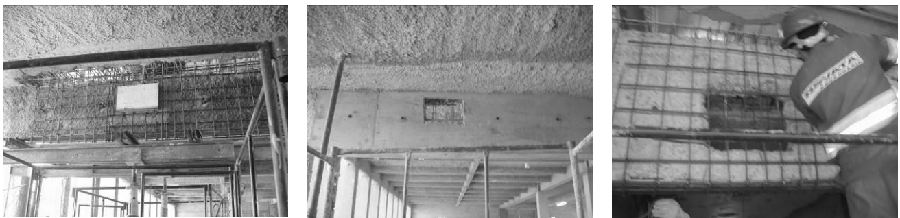
Figura 4 - Reforço em vigas para passagem de duto e fechamento das aberturas antigas.
