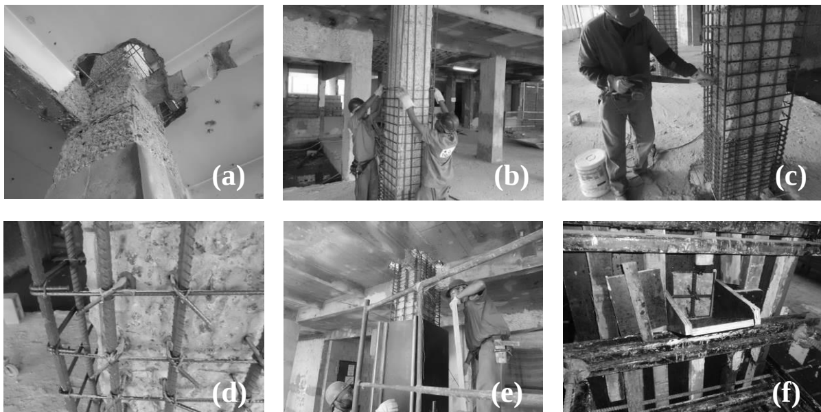
Figura 6 - Reforço em pilar com armadura aparentemente flambada: (a) Apicoamento da superfície e abertura da laje; (b) Posicionamento das armaduras; (c) Abertura e limpeza com ar sob pressão dos furos para ancoragem; (d) Ancoragem química, tipo injetável; (e) e (f) Posicionamento da fôrma, com previsão de janelas, para garantir que a altura máxima de lançamento do graute não seja maior que 1,20m.
