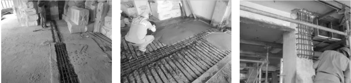
Figura 5 - Reforço em viga devido à ausência de pilares, incluindo “sulco” na laje e detalhe de ancoragem no pilar.
