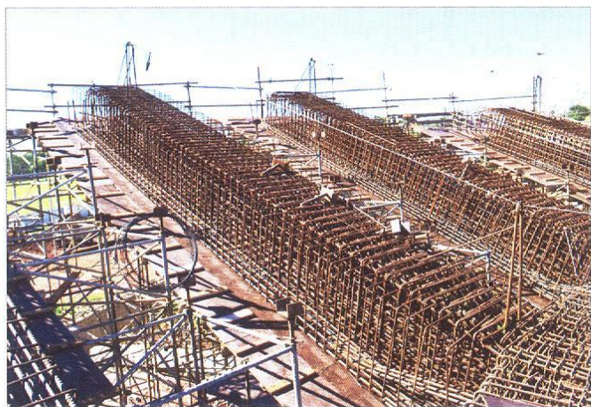
▶ Figura 7 Aquário do Pantanal: trechos de armadura de vigas e lajes
