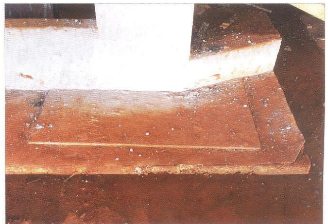
► Figura 11 Detalhe das chapas de distribuição abaixo dos cantos dianteiros da laje de fundo
