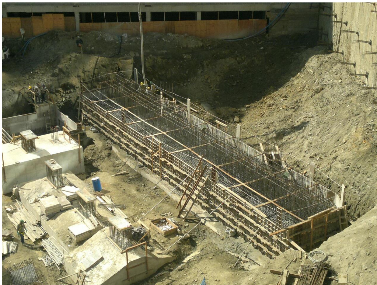
Figura 5 – Evento de concretagem da Sapata S3B .
