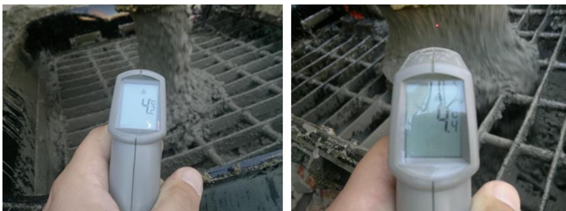
Figura 7 – Exemplo da aferição da baixa temperatura de lançamento do concreto durante a execução da primeira camada da Sapata S3B (data 09/05/2013).
