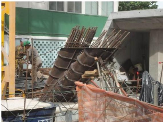
(a) Detalhe da fôrma metálica do protótipo inclinado em escala real, precedentemente a concretagem.
