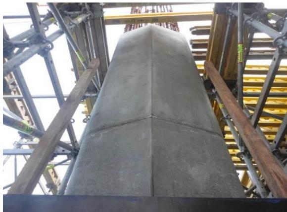
(a) Detalhe de um tramo de pilar em concreto aparente já desformado, parte superior.
