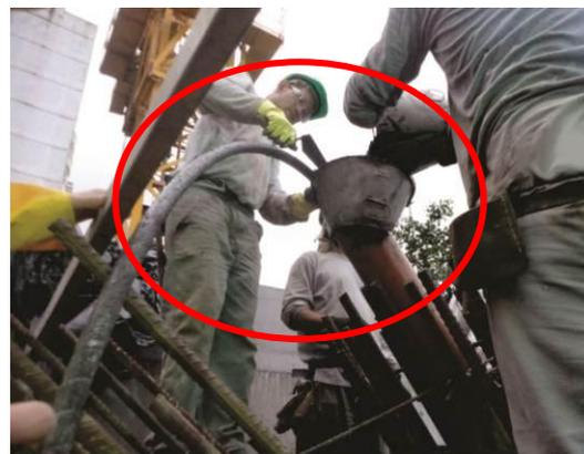
(d) Detalhe do mangote do vibrador introduzido no interior do tubo de transporte do concreto.
