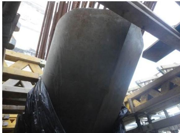
(b) Detalhe de um tramo de pilar em concreto aparente já desformado, parte inferior.
