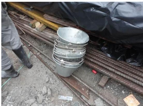
(c) Detalhe dos baldes para lançamento do concreto em pequenas porções.
