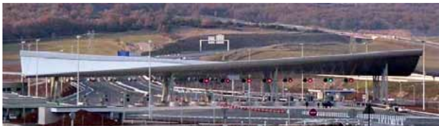
Figura 21 – Posto de Pedágio do Viaduto Millau, França.
