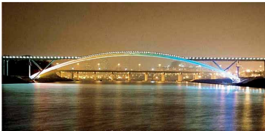
Figura 20 – Passarela Seonyu, Coréia do Sul.
