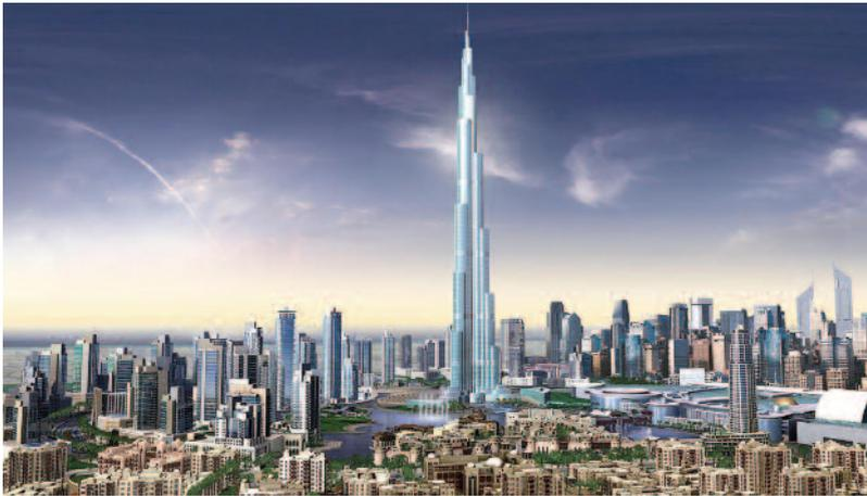
Figura - 12. Torre (burg) Dubai, nos Emirados Árabes. Estrutura mais alta do mundo com cerca de 750m de altura, em concreto. Está em construção e tem previsão para inaugurar em 2008.
