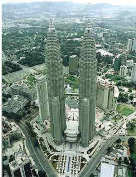
Figura 11 - Petronas Tower, em Kuala Lumpur, Malásia, primeiro edifício em concreto de alto desempenho que superou em altura os edifícios metálicos, 1997. (<http://www.diritto-internazionale.com/guide/Petronastower2.jpg>)
